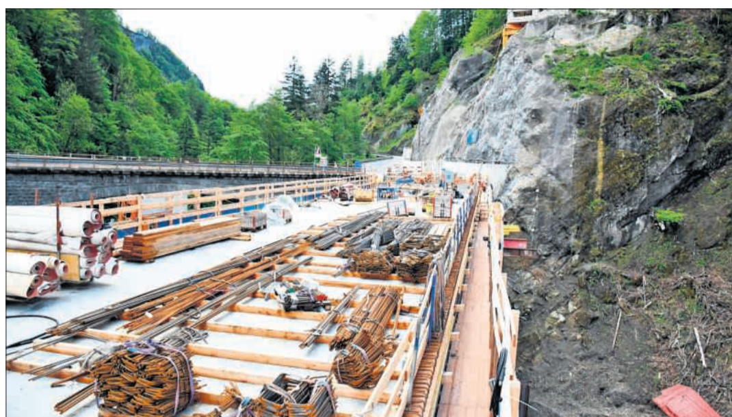
Der Mittelteil der Brücke ist bereits betoniert; bis zum Tag der offenen Baustelle wird die ganze Brücke begehbar sein.
