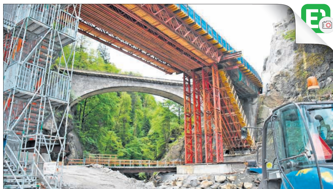
Das aufwendige Gerüst zur Erstellung der Brücke wirkt von unten betrachtet imposant. [Bilder Sybille Weber]
