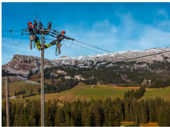
Netzelektriker der CKW mit der Schratzenfluh im Hintergrund (Foto: CKW)
