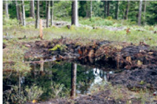
Mit Spundwänden eingestauter Entwässerungsgraben in einem Hochmoor (Foto: T. Koch)
